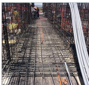
Obra gruesa piso 9
